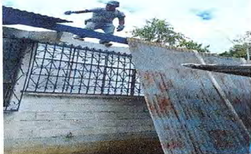
Foto 1: Desmantelamiento de las láminas de zinc en la parte de atrás de las aulas.
