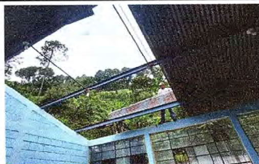
Foto 6: Techado una de las aulas donde presentaba agujeros en las láminas están siendo desmanteladas.
