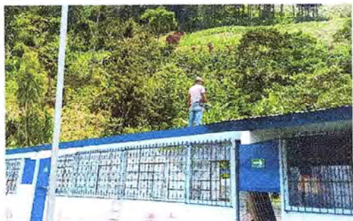
Foto 3: Parte frontal de la escuela donde están siendo desinstaladas las láminas de zinc deterioradas y oxidas.
