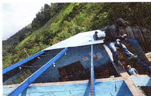
Foto 2: La totalidad de láminas de zinc están siendo sustituidas por láminas troqueladas calibre 26.
